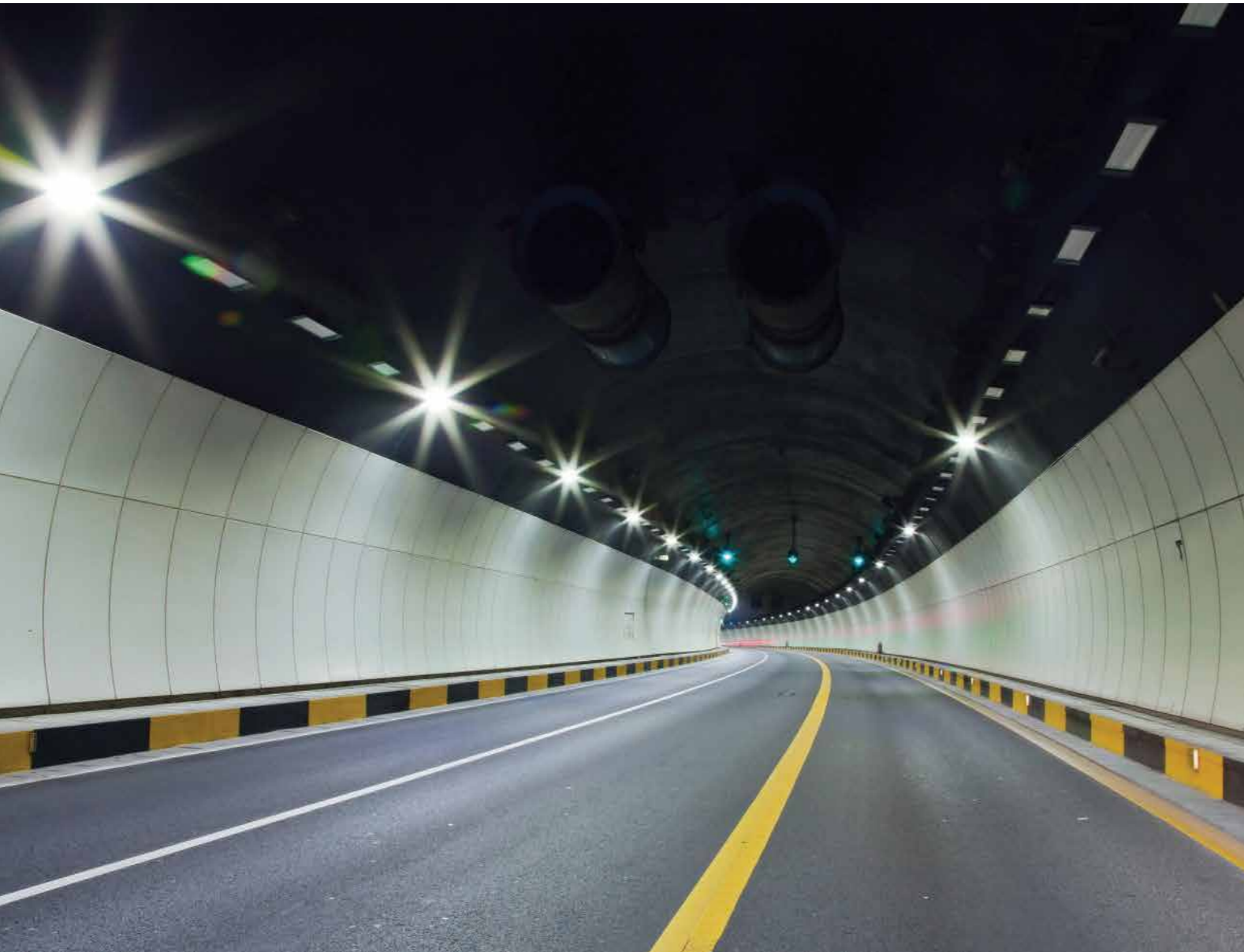
Da Mei Sha Tunnel, Shenzhen, China
